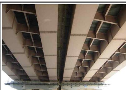
Steel Box Girder(외부) 전경
