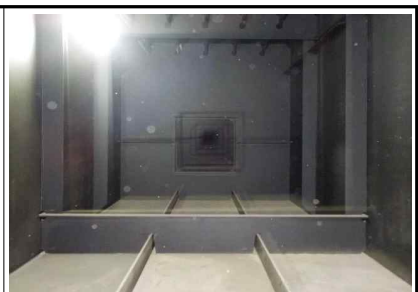
Steel Box Girder(내부) 전경
