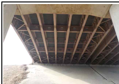
Steel Plate Girder 전경
