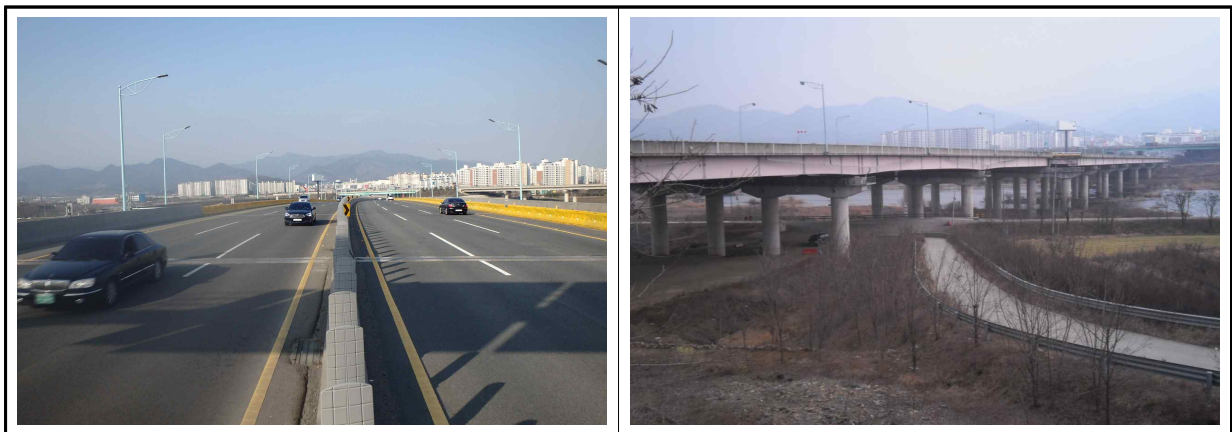
<사진 2.1.1> 범안대교 전경
