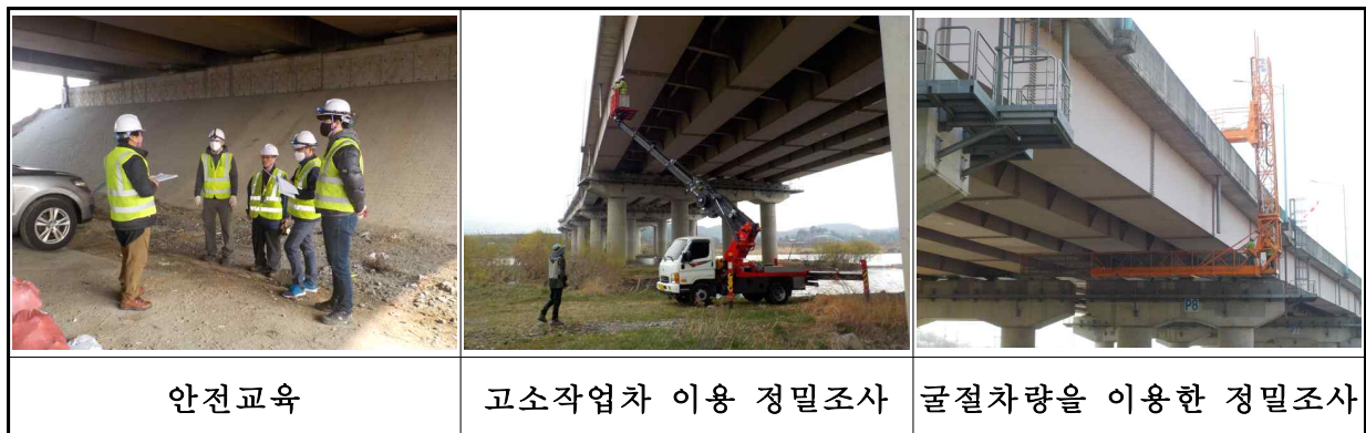
<사진 2.1.2> 외관조사 현황
